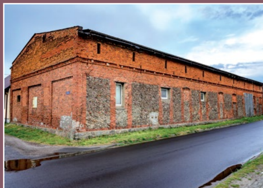
Budynek gospodarczy w Śmieszkwie Wirtschaftsgebäude in Śmieszkwie
