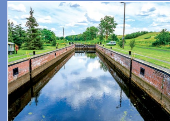
Śluza na Noteci Schleuse an der Netze
