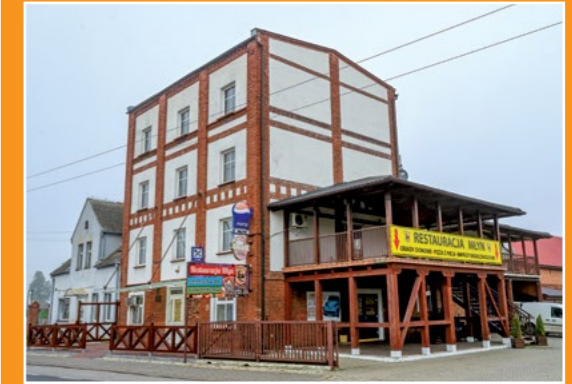
Restauracja Młyn w Hucie Restaurant Mühle in Althütte
