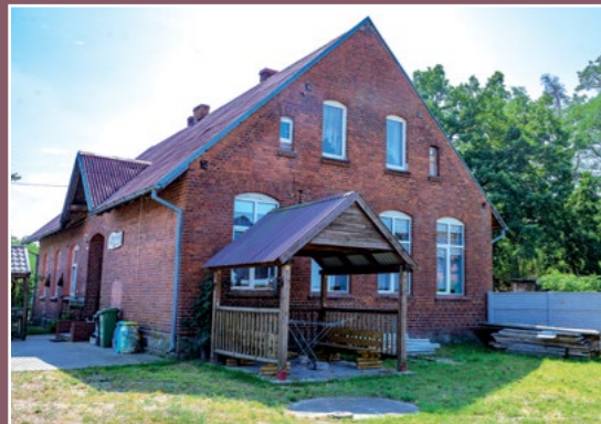
Szkoła w Bukowcu Schule in Buchwerder
