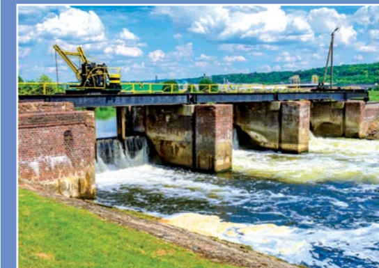
Jaz na Noteci Stauwehr an der Netze
