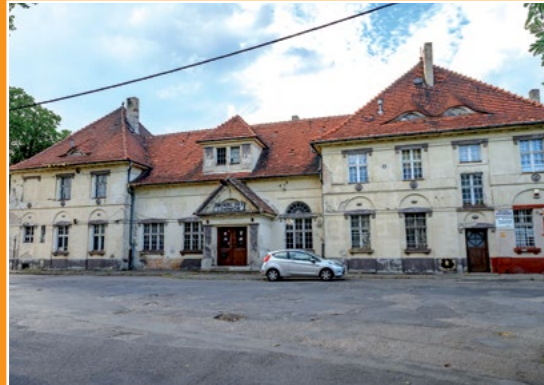
Dawny dworzec kolejowy w Czarnkowie Alter Bahnhof in Czarnikau
