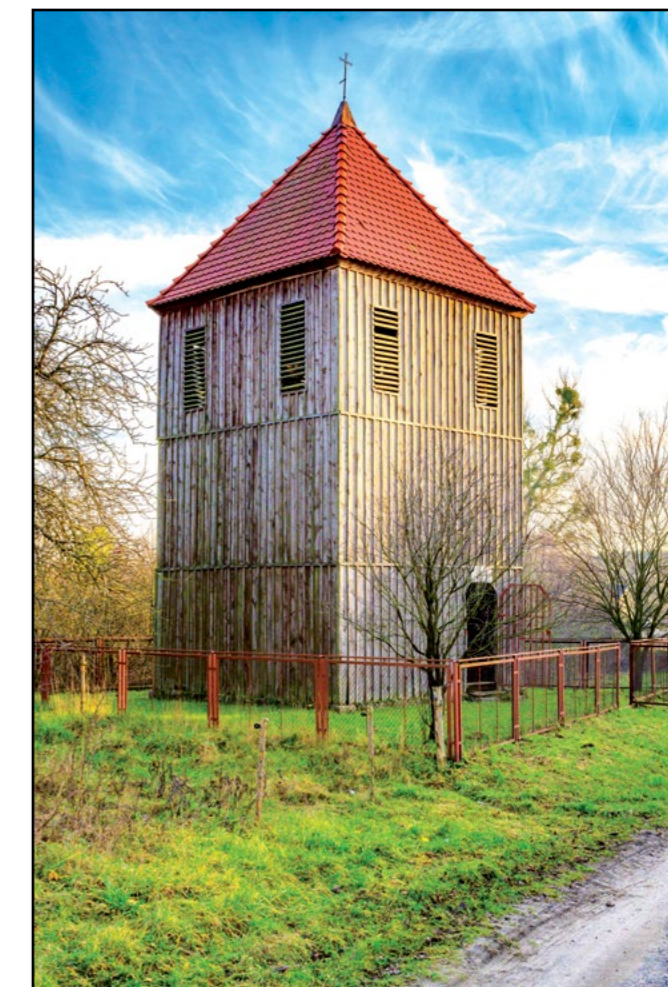
Dzwonnica w Radosiewie Glockenturm in Radosiew
