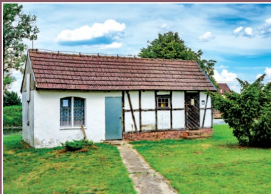
Budynek na śluzie Mikołajewo Gebäude an der Schleuse in Mikołajewo
